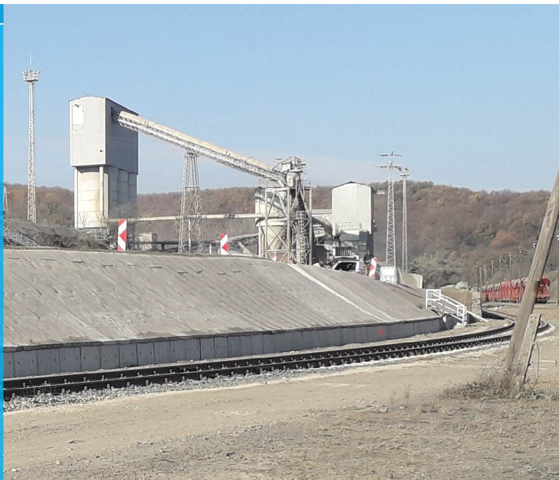
Az elkészült rézsűvédelem egy szakasza
